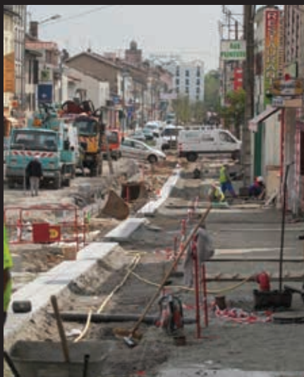
Pendant les travaux
