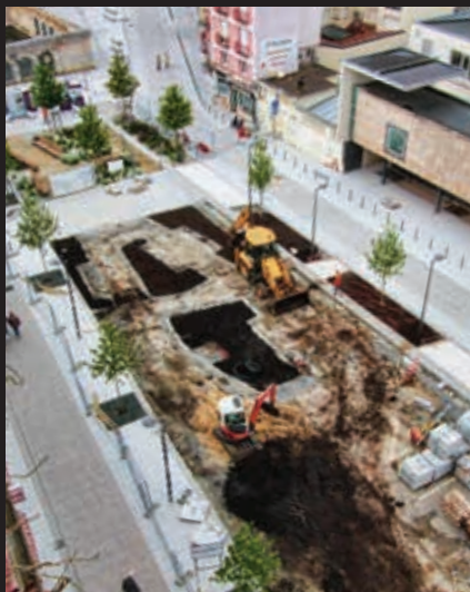
Pendant les travaux
