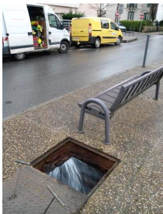
Si la réparation de la fuite du Boulevard Carnot (février 2015) a largement contribué à l'amélioration de la performance du système de distribution, il est important de noter que d'autres actions correctives sont engagées depuis 2012 : mise en place de loggers, contrôle des purges et vidanges, contrôle vannes, recherche visuelle, remplacement compteur et individualisation des comptages, etc...
