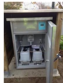
En 2017, 8 surverses significatives, identifiées lors de la première étape du Schéma Directeur d'Assainissement, sont équipés de débitmètre.. La surverse de BERDOT (poste majeur du réseau d'assainissement) est également équipée d'un préleveur fixe pour évaluer la charge polluante. ouvrages d'épuration
