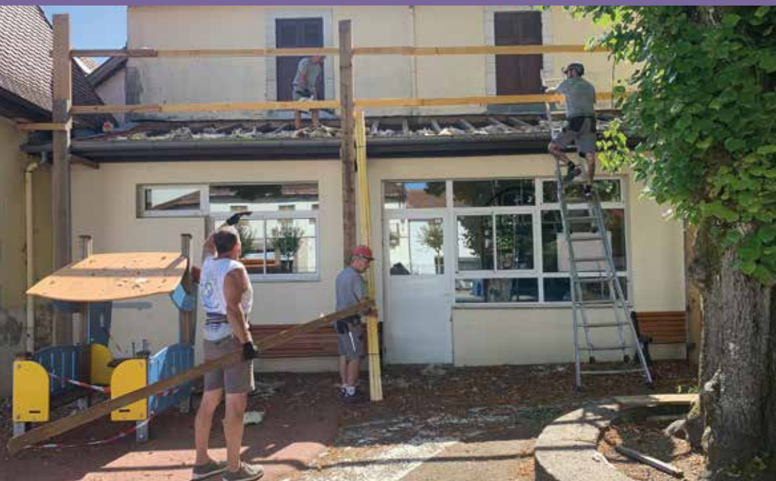
La toiture de la véranda de l'école maternelle Galliéni a été totalement refaite cet été.
