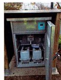
Neuf surverses significatives, identifiées lors de la première étape du Schéma Directeur d'Assainissement, sont équipés de débitmètre. La surverse de BERDOT (poste majeur du réseau d'assainissement) est également équipée d'un préleveur fixe pour évaluer la charge polluante.
