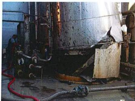
En 2016, le service a fait face à **l'éventration du fermenteur 5**, causée par un arrachement du collage liant la virole au fond conique de la cuve.
