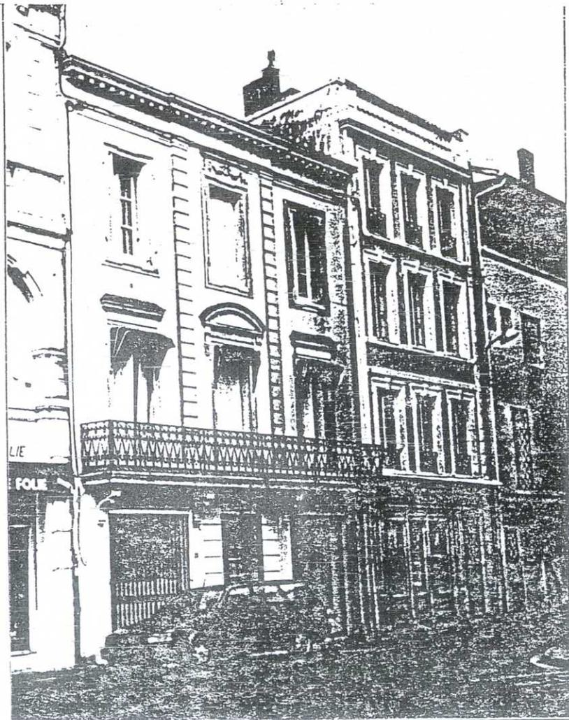
. modénature de pierre comprenant corniche en couronnement, encadrement de baies, chaînages aux angles et pour relier verticalement et horizontalement les ouvertures en pierre taillée à appareillage caché.
