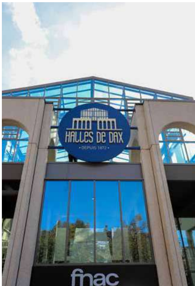
Nouvelles Halles de Dax
