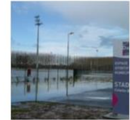
inondation 2014 -stade Colette Besson
