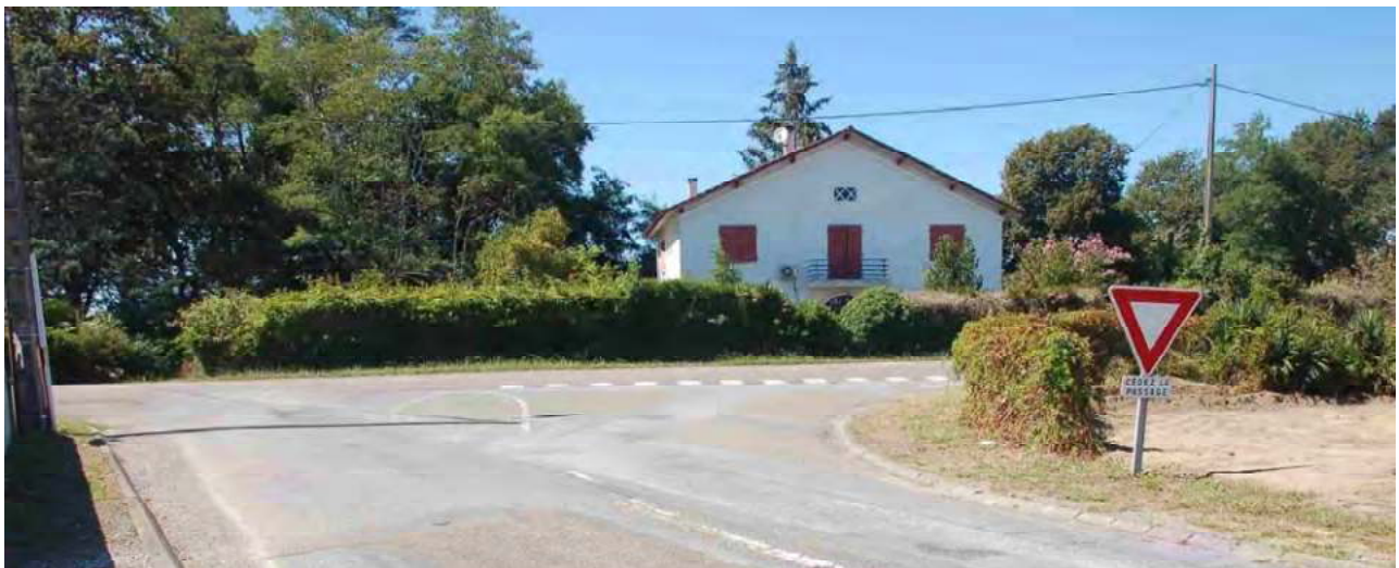
Photo 6 : Le carrefour entre la route de l'Aiguille (premier plan), qui sert d'exutoire au lotissements actuels donnant sur cette voie et au futur lotissement objet du PA2, et la RD6 (second plan) sera certainement à modifier et sécuriser pour tenir compte du trafic ajouté.
