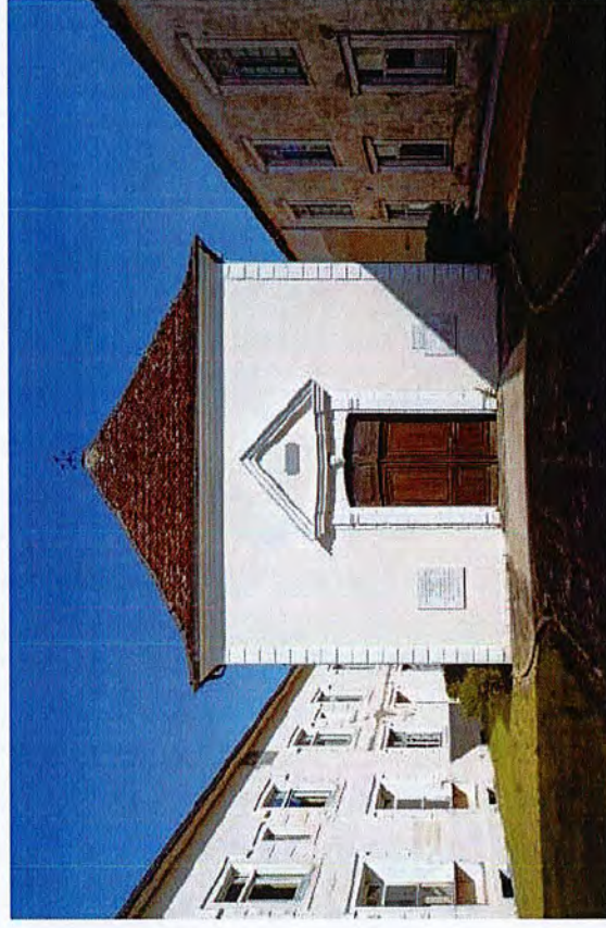
L'Hôpital thermal, un monument non protégé
