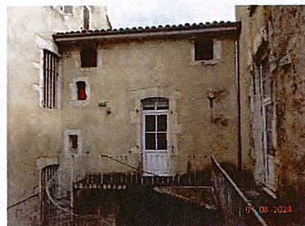
Le rez-de-chaussée et le 1<sup>er</sup> étage sont par endroits dans un état dégradé dû à la durée de vacance des locaux et aux infiltrations de la verrière et de la couverture en amiante. Les fenêtres sont en PVC double vitrage.
